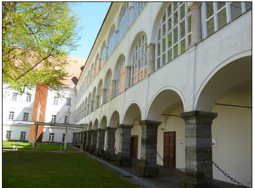
Abbildung 88: Innenseite Marienhof des Südtraktes, Pfeilerarkaden im EG und mit kleinteilig verglaste Säulenarkaden in den beiden Obergeschoßen.
